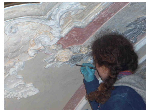
Fase di puliture degli stucchi.
