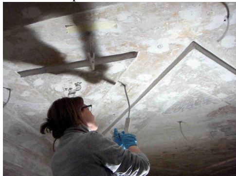
Consolidamento del soffitto.
