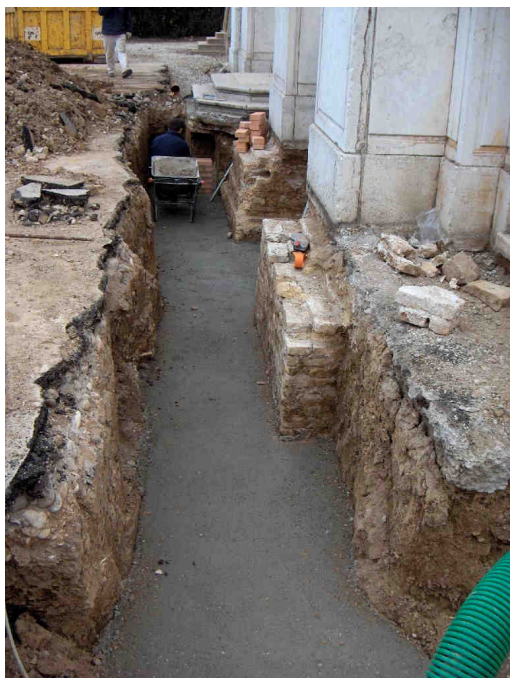
Fase esecutiva della trincea di drenaggio e consolidamento fondazionale
