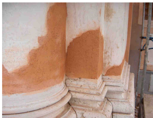
Particolare di facciata in restauro.
