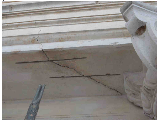
Trabeazione di facciata, fase di cucitura delle fenditure.
